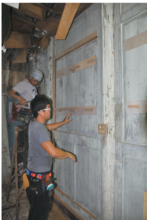
圖 23 彩繪牆板背面結構加固情況
