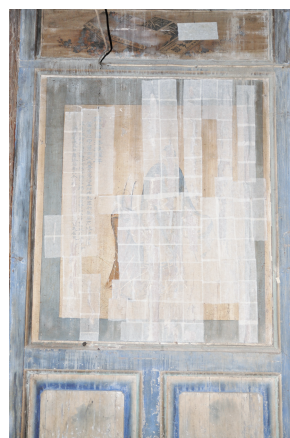
圖 18 暫時性加固完表面乾燥後
